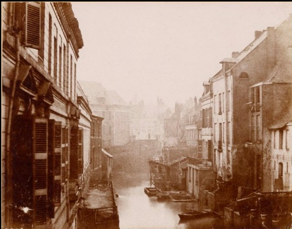
Canal de la Baignerie
