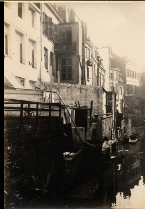
Canal de l'Arc
